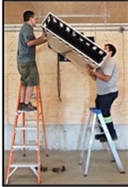
3. Serrez le plénum au boîtier SS en ajustant les six attaches. Assurez-vous qu'ils soient suffisamment serrés pour assurer une bonne étanchéité (voir IMAGE 10).
