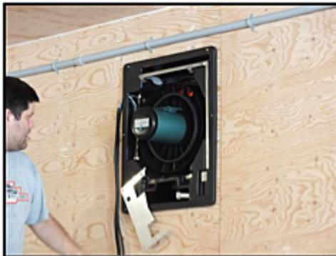
3. Vissez le module de ventilation au mur à l'aide des six vis en acier inoxydable fournies par l'ESA, trois à gauche et trois à droite. Vous pouvez visser le plastique de chaque côté du module de ventilation comme indiqué ci-dessous. Pour une résistance maximale, assurez-vous de visser dans les goujons qui ont été utilisés pour encadrer le trou.
