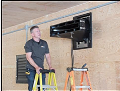
3. Repoussez le haut du plénum jusqu'à ce que le bord supérieur glisse dans la douille sous la poignée.
