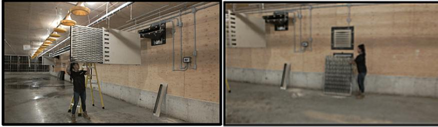
7. Nettoyez l'extérieur du cœur de l'échangeur. Utilisez de l'air comprimé ou de l'eau. Ce nettoyage peut être effectué à l'intérieur ou à l'extérieur du bâtiment. Vous pouvez également décider d'insérer un cœur d'échangeur de chaleur de rechange si vous en possédez un.
