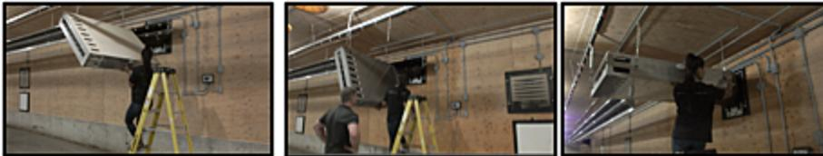
14. Serrez les fixations entre le plénum et le boîtier SS.
