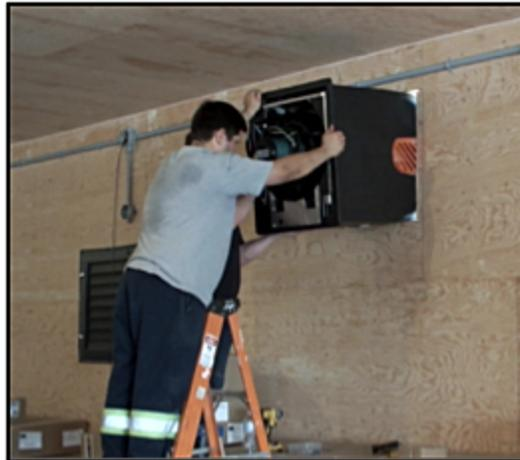
2. Faites glisser le module de ventilation à fond dans le trou, jusqu'à ce qu'il effleure le mur de tous les côtés. Assurez-vous que l'unité est à l'endroit en gardant le canal de drainage vers le bas (voir IMAGE 3).
