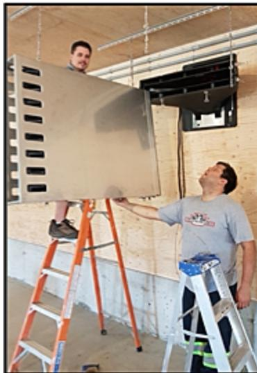
2. Soulevez le boîtier SS en position horizontale et attachez les deux autres chaînes / crochets. Il doit y avoir une légère inclinaison vers le mur pour évacuer la condensation (voir IMAGE 9).
