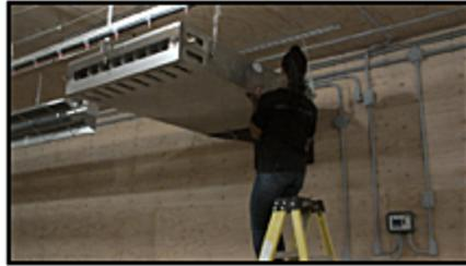
4. Descendez le boîtier SS en position verticale en retirant les crochets du côté droit.
