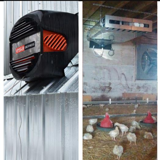
Le **ESA-1000** permet de préchauffer l'air entrant dans un bâtiment en utilisant l'air chaud normalement expulsé à l'extérieur. Son installation est un investissement rentable. Récupérez rapidement les sommes investies grâce aux économies réalisées et à l'augmentation de votre rendement.
