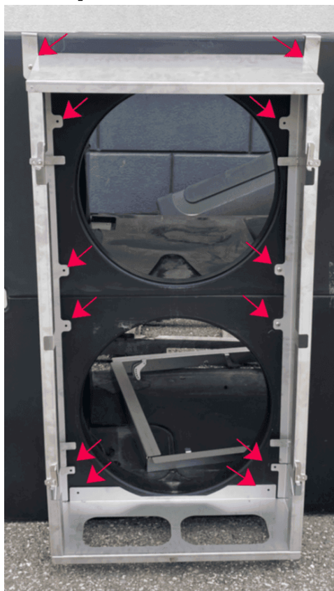
Figure 38 Indications des positions des vis pour la fixation du cadre
